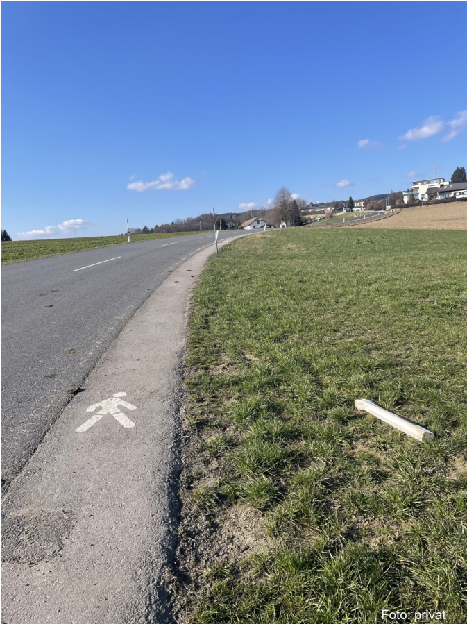
Die Leitpflocke sind teilweise aus ihrer Verankerung gerissen, beschädigt sind alle entlang dieses Teilabschnitts der Derflerstraße
