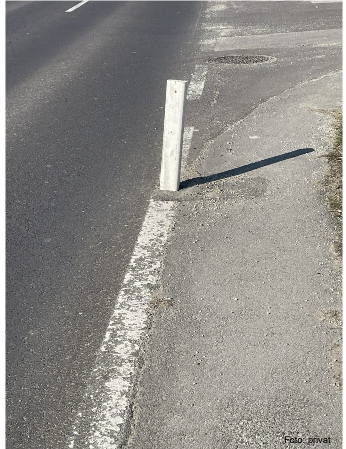
Die Leitpflocke sind teilweise aus ihrer Verankerung gerissen, beschädigt sind alle entlang dieses Teilabschnitts der Derflerstraße
