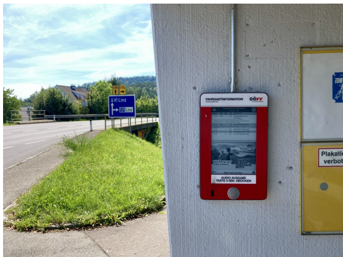
Eine digitale Busanzeige wie z.B. in der Gemeinde Engerwitzdorf wird auch bald in Lichtenberg installiert. Foto: privat
