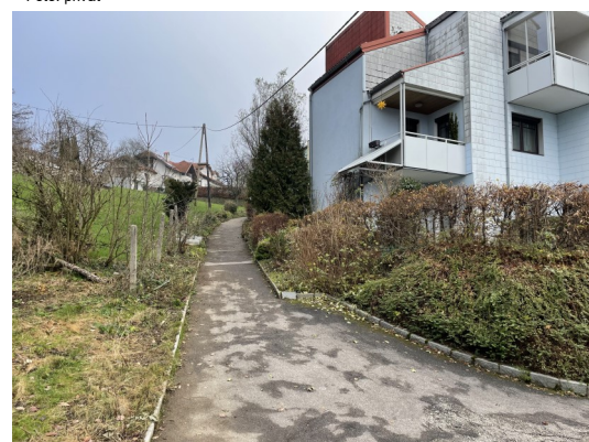
Der vorhandene Gehweg wird zur Rettungszufahrt ausgebaut.
